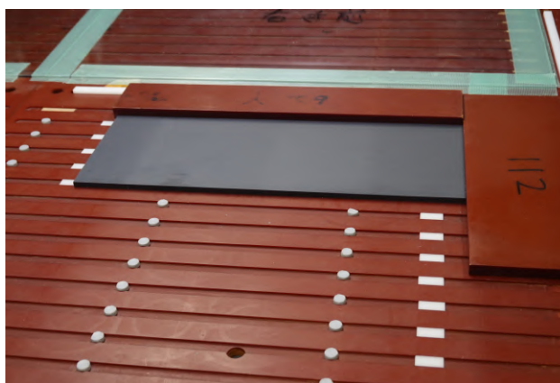
図3 材料を固定するための作業
